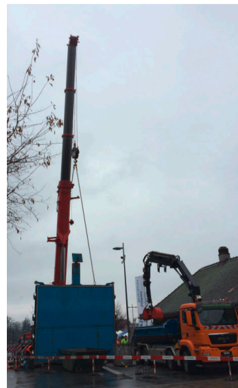
Mit schwerem Gerät starteten gestern die Inspektionsarbeiten. sgt
